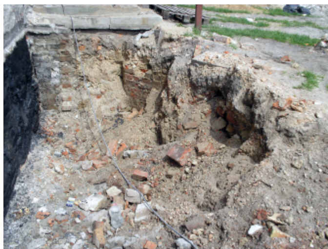
Odkryte w ziemi pozostałości rozebranego trzeciego skrzydła (fot. 5)
