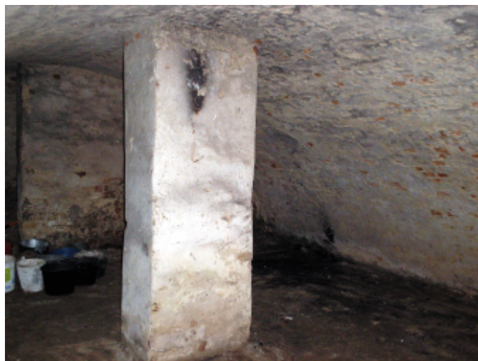
Piwnice pod byłą Misją Jezuicką (fot. 3)
