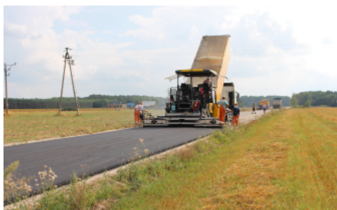
Budowa drogi w Olszankach.
