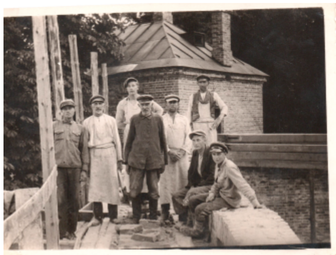
Budowa łącznika między budynkiem misji i progimnazjum (fot. 7)
