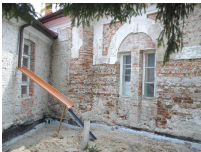
Remont budynku dawnej misji jezuickiej (fot. 8 i 9)
