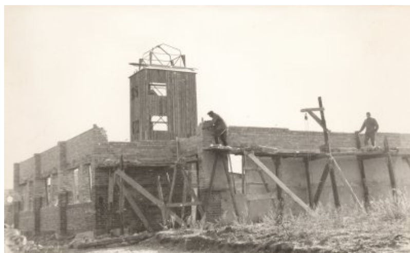
Budowa Domu Strażaka.
