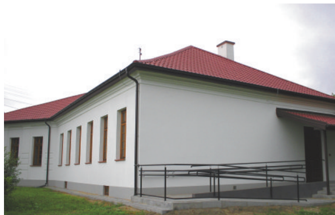
Budynek po starym przedszkolu po pierwszym etapie modernizacji.
